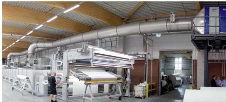
Der Kanalabscheider (rechts) im Abluftstrang des Spannrahmens.
