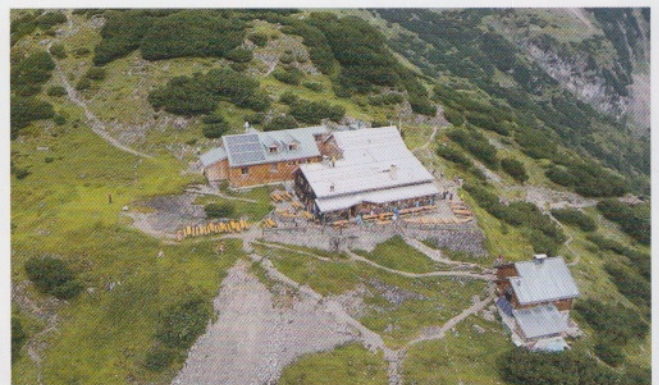
Bild: Tesvolt GmbH
