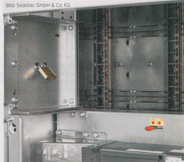
Bild 6 | In Öffnungen der seitlichen Führung lässt sich ein Vorhängeschloss anbringen. Das sichert gegen unbefugtes Einsetzen des Steckmoduls.
