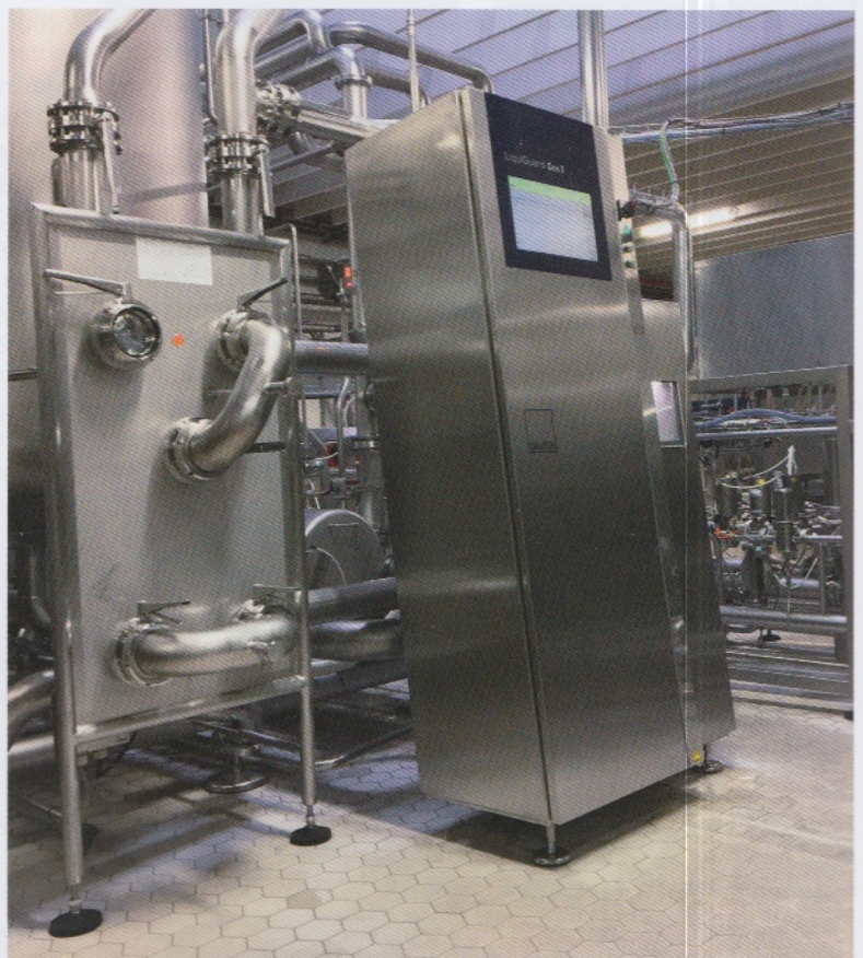
Design ist kein Selbstzweck: Auf dem Gehäuse des LiquiGuard Gen3 können keine Flüssigkeiten stehen bleiben und der Bildschirm ist leichter abzulesen. Foto: DAUSCH Technologies
