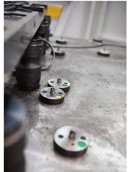
Damit die Werker bei der hohen Komplexität noch den Überblick behalten, sind die für das jeweilige Bauteil passenden Positionen farbig codiert.
