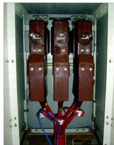
Bild 2: Die Stromversorgung wurde vom gelöschten 10-kV-Netz auf das niederohmige 10-kV-Netz der Netzdienste Rhein-Main umgestellt.
