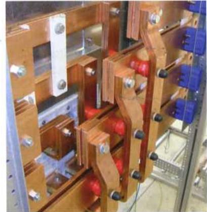
eingespart werden. Die Hauptsammelschienensysteme bleiben in der Standardlage und enden leiterversetzt auf Höhe des Schalteranschlusses. Dadurch sind keine zusätzlichen Hauptsammelschienen nötig. Die aufwendige, materialintensive Führung des Sammelschienensystems über mehrere Etagen zum Kuppeln entfällt vollständig.
