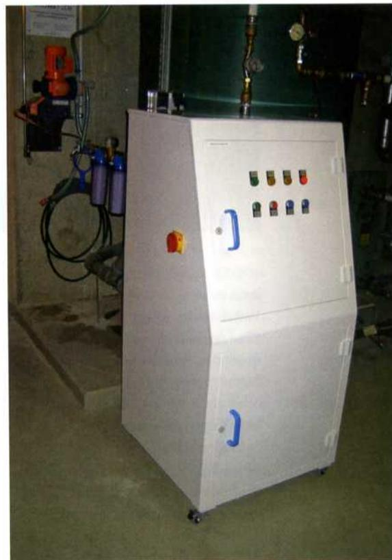
▲ Aus einer Kochsalzlösung mit 0,45 % NaCl-Gehalt entsteht in einer durch eine Membran geteilte Elektrolysezelle das Fluidum Anolyte. Es ist hoch bakterizid, virizid und fungizid und wirkt unmittelbar auch in weit verzweigten Leitungssystemen. Dabei ist es ph neutral und für Menschen völlig ungefährlich.
