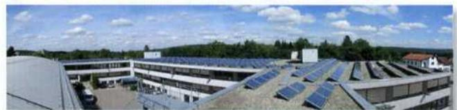
Die Telegärtner Karl Gärtner GmbH in Steinenbronn hat auf dem Dach ihres Firmengebäudes eine Solaranlage errichtet und deckt damit künftig bis zu 15% ihres Jahresstrombedarfs. Die Ende Juni 2010 in Betrieb genommene Photovoltaikanlage besteht aus 410 Solarpanels auf über 2000 m<sup>2</sup> Dachfläche.
