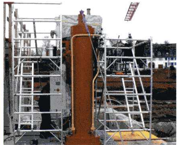
Einbaulage des Zylinders vor Ort: Die über 13 Meter lange Einheit öffnet und schließt zu Wartungszwecken einen Dammbalken hinter der Turbine des Wasserkraftwerks bei Leibstadt. (Schweiz).
