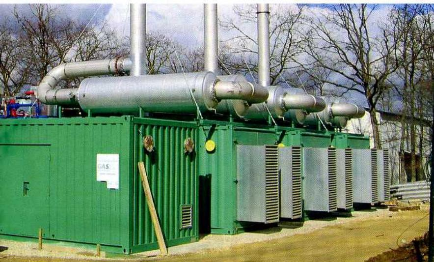
Pluspunkt Container: Die Maße sind bis 15x3,5x3,5 m frei skalierbar; die Technik kann schon in der eigenen Werkstatt vorinstalliert werden.
