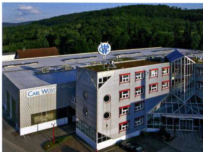
Bild 2: Firmengebäude (Werkbilder: Carl Wüst GmbH & Co. KG, Remshalden)
