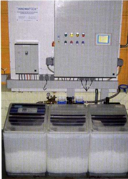
③ Das Anolyte-Verfahren steht für eine interaktive, membran gesteuerte elektrochemische Aktivierung und erzeugt mittels einer Membranzellen-Elektrolyse ein stark desinfizierendes metastabiles Wasseragens.
