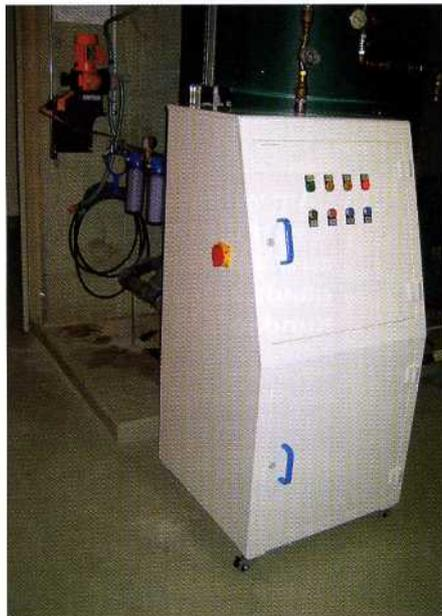
④ Aus einer Kochsalzlösung mit 0,45 % NaCl-Gehalt entsteht in einer durch eine Membran geteilten Elektrolysezelle das Fluidum Anolyte. Es ist hoch bakterizid, virizid und fungizid und wirkt unmittelbar auch in weit verzweigten Leitungssystemen. Dabei ist es ph-neutral und für Menschen völlig ungefährlich.
