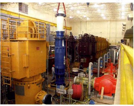
Bild 2: Ritz Pumpe (blau) vor dem Absenken auf 80 Meter Wassertiefe. Im Betrieb ist sie weder zu hören noch zu sehen.
