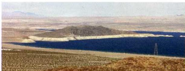
*Die Pumpstation liegt auf der ehemaligen Insel. Durch Absinken des Wasserpegels um 30 Meter (weißer Rand) in den letzten Jahren muss die Pumpstation neu geplant werden.*
