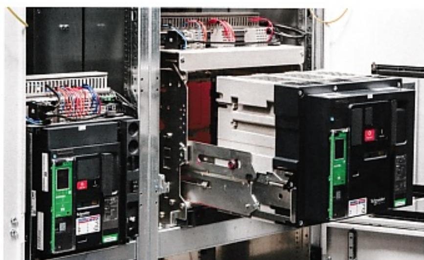
Bild 3 | Mit den Masterpact MTZ von Schneider Electric kommen offene Leistungsschalter der neuesten Generation zum Einsatz.
