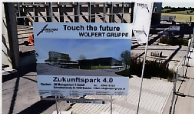
Mit dem Bau einer neuen Firmenzentrale, einer Fertigungshalle und einer Ausbildungsakademie stellt Wolpert die Weichen für die Zukunft. Foto: Wolpert
