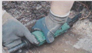
Schnell zu montieren und unbegrenzt lagerfähig – Gelmuffen sind eine zeitsparende Alternative zur Gießharz- oder Warmschrumpfmuffe bei der Verbindung von Leitungen. Doch nicht jede Gelmuffe ist für jeden Einsatz im Erdreich geeignet. Denn wenn es darum geht, Erdkabel verlässlich und dauerhaft zu verbinden, kommt es vor allem auf die drei Faktoren mechanischen Schutz, Isolation und Abdichtung an.
