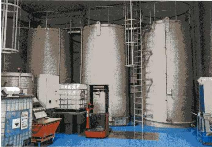
Gesammelt wird das zugeführte Prozesswasser zunächst in drei 24 m<sup>3</sup> fassenden Rundbehältern.
