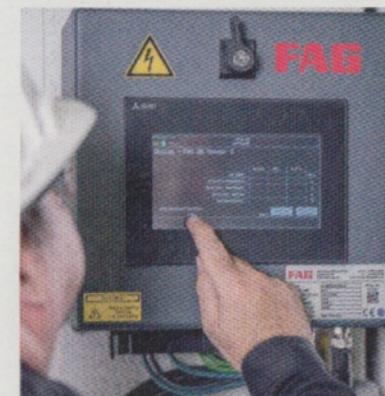
*Der FAG SmartQB misst Schwingungen von Maschinen und erstellt darauf basierend Handlungsempfehlungen. Im SmartQB ist das Maschinenprotokoll SLMP (Seamless Message Protocol) implementiert, über das die Schwingungssensoren mit der speicherprogrammierbaren Steuerung (SPS) von Mitsubishi Electric kommunizieren und Kennwerte weitergeben. Die SPS verarbeitet die Daten zu Informationen, die als Klartextmeldungen aufbereitet auf dem Display angezeigt werden. Bild: Schaeffler*
