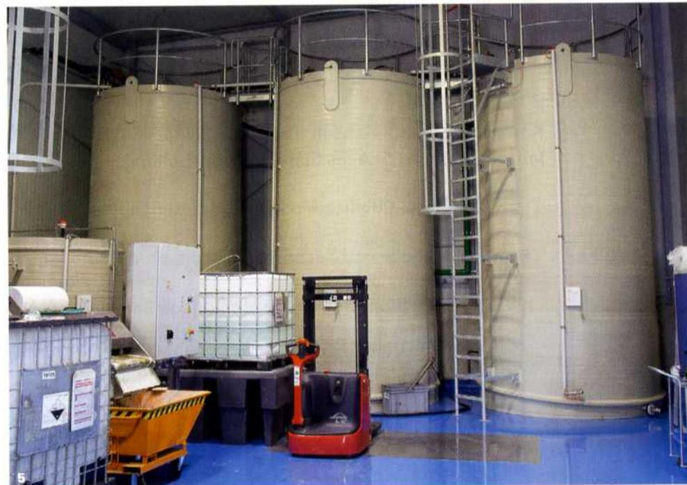
**3** Der Fremddölabscheider TB 800 funktioniert nach dem Koaleszenzprinzip und trennt Prozessmedien von Fremddölen.
