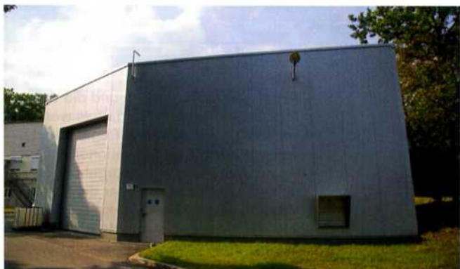
Bild 11: Das Gebäude wurde von der Serviceabteilung der RUAG für die Anlage geplant und gebaut (Werkbilder: MKR Metzger GmbH, Monheim)
