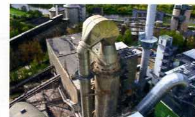
Heidelbergcement-Werk spart 150.000 kWh pro Jahr bei der Druckluftversorgung
