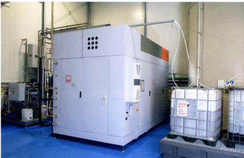
**Die energieeffiziente vollautomatische Verdampferanlage ET 1500 von MKR Metzger kann pro Stunde 1.500 Liter Prozesswasser verarbeiten.**
