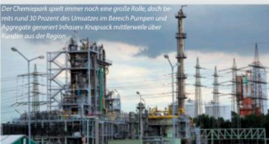
Der Chemiepark spielt immer noch eine große Rolle, doch bereits rund 30 Prozent des Umsatzes im Bereich Pumpen und Aggregate generiert Infraser Knapsack mittlerweile über Kunden aus der Region.
