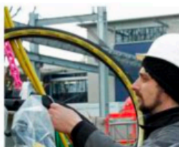
Contitech lieferte für das Projekt einen trinkwassertauglichen Schlauch. Dieser musste dem hohen Außendruck von 10 bar in einer Wassertiefe von 100 Metern widerstehen.
