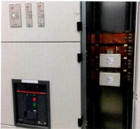
**Bild 4** | DehnShort erkennt den Störlichtbogen bereits beim Entstehen und schaltet diesen in Bruchteilen einer Sekunde ab, sodass dessen Auswirkungen auf ein ungefährliches Maß reduziert werden.
