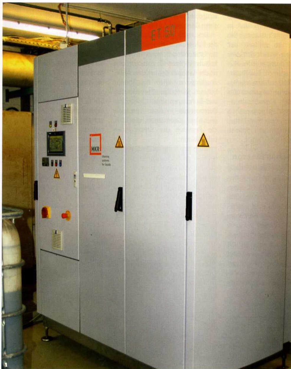
1 Der Verdampfer »ET50« von MKR Metzger hat eine Prozesswasserleistung von 50 Liter pro Stunde.
