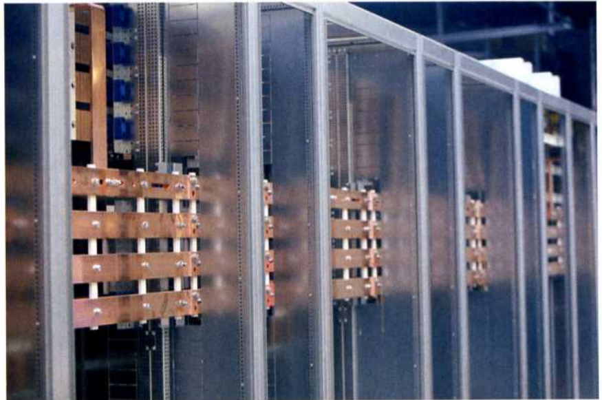
Bild 3 | Da Sedotec auch Spezialist in der Kupferbearbeitung ist, bestellt Carl bei Bedarf die komplette Verschienung der Anlage im Feld vormontiert. Im Kupfer-Anschlusskit sind alle erforderlichen Kupferschienen, Stützstreifen und Kleinteile enthalten.
