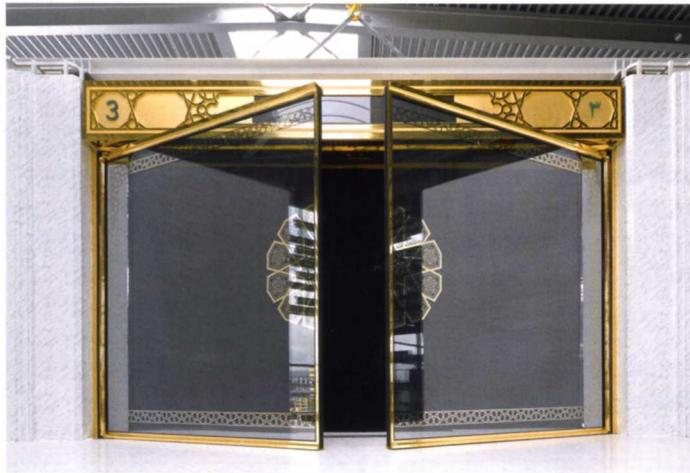
**Tor für die Erweiterungsbauten der heiligen Moschee in Mekka - Tonnen-schwere Glasflügel, die von Profilen aus vergoldetem Duplexstahl eingefasst sind**
