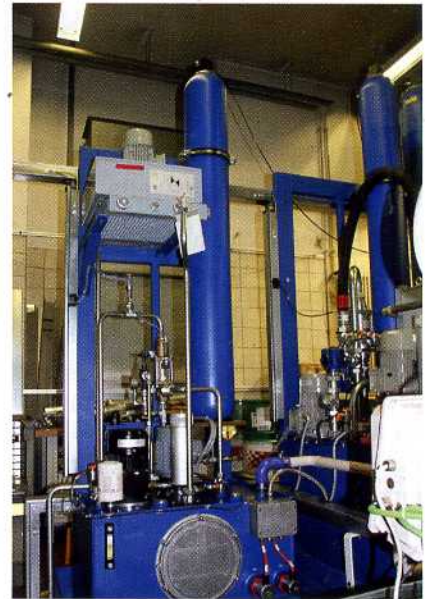
Wichtiger Bestandteil und ein Grund für die günstige Betriebskostenstruktur der Gesamtanlage ist die Hydraulikeinheit von Bott, die eine hydrodynamische Rotorlagerung der Welle ermöglicht
