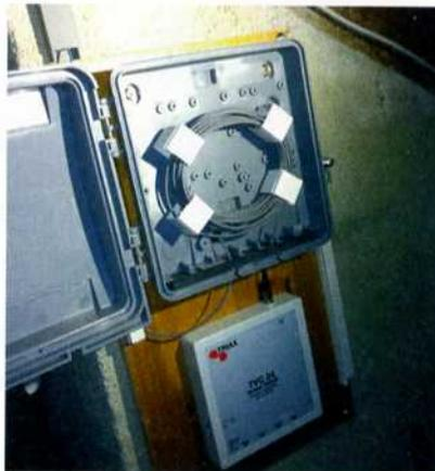
**Bild 9:** Installation im Dachgeschoss: Multiplexer und Spleißbox (B3 Future Technologies)
