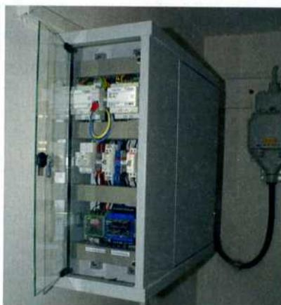
**Bild 10:** Zentraler Schrank für die Sat-ZF-Verteilung, Fernüberwachungsgeräte (Rutenbeck) und Stromversorgung
