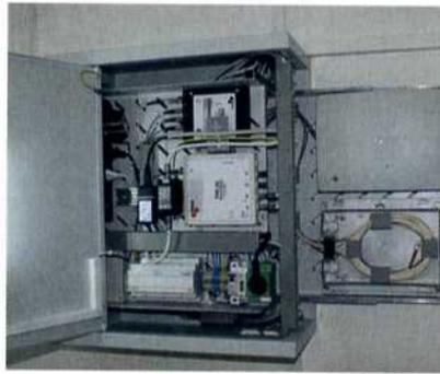
**Bild 8** Zentraler Schrank (Schäfer) mit den aktiven und passiven Komponenten, hinten: Teleskopauszug mit Spleißboxen (Telegärtner) für die Faseraufnahme
