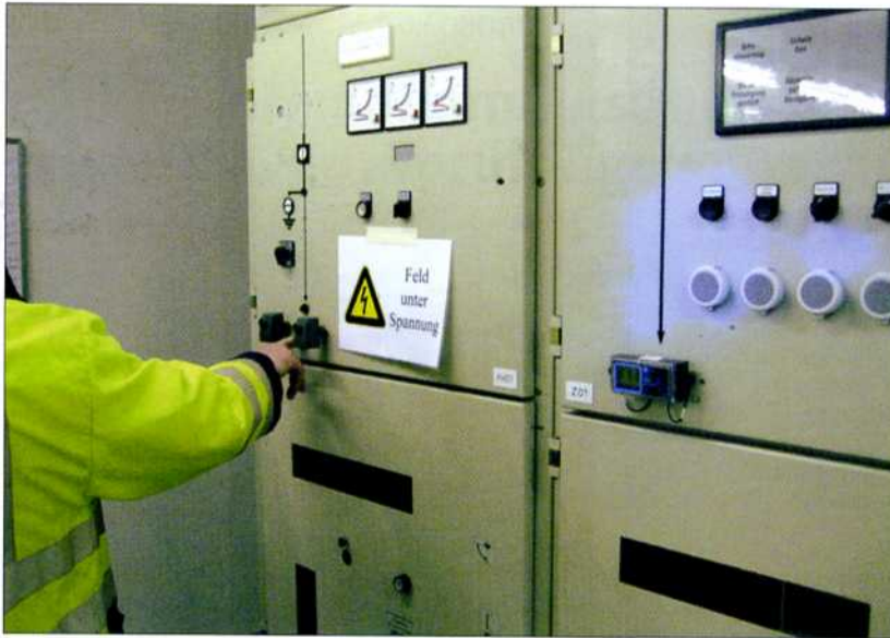
Bild 3: Die alten, steckbaren Spannungsprüfsysteme müssen regelmäßig geprüft werden, was einen enormen Zeit- und Personalaufwand erfordert.
