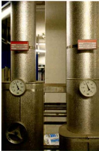
Durch die neue Art der Wasserdesinfektion konnte die Warmwassertemperatur in den Leitungen gesenkt werden, was letztendlich Energiekosten spart.
