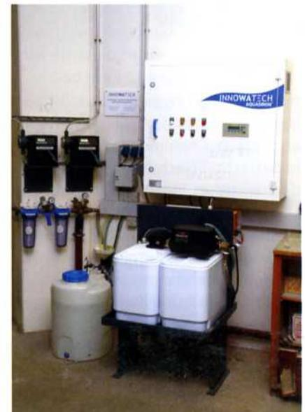
Ein Vorratstank sichert die Verfügbarkeit des Desinfektionsmittels auch in Verbrauchsspitzenzeiten. Der Hersteller liefert die Anlagen mit unterschiedlichen Produktionskapazitäten – je nach hohem, mittlerem oder niedrigem Wasserbedarf.
